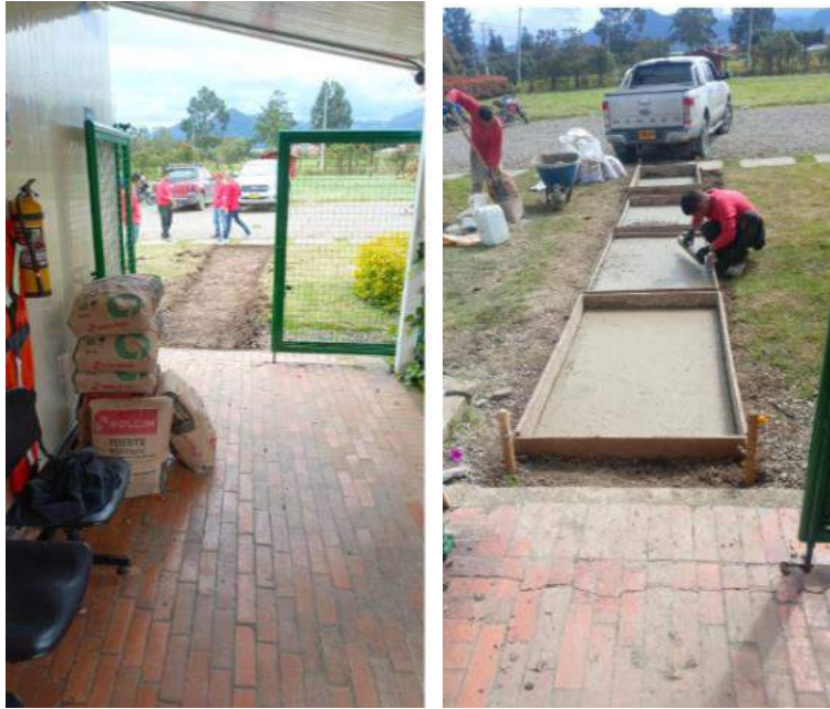
Imagen Nro. 57 Y 58. adecuación de accesos principales
