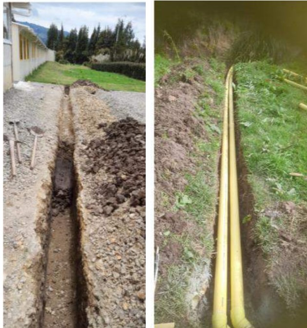
Imagen Nro. 59 y 60. Mantenimiento y arreglo de caja de aguas lluvias
